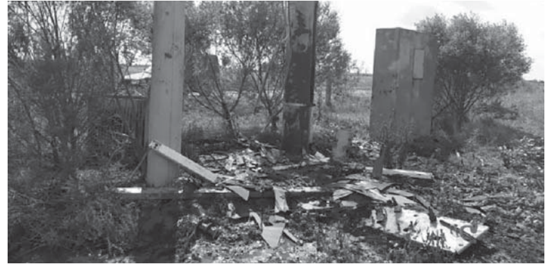
Desolador. Así quedó la planta transmisora. - LT3 -
