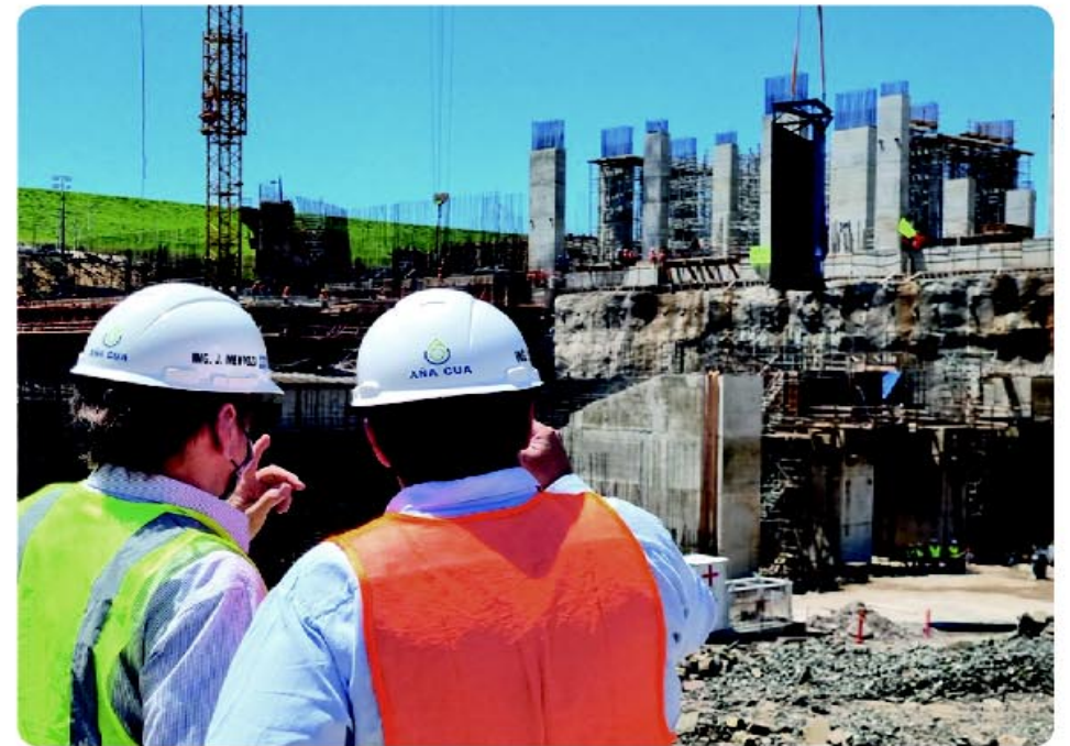
Construcción del brazo Añá Cuá
