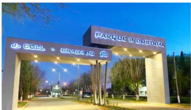
Parque Industrial de Bragado un lugar donde se terminan las decisiones conjuntas y sociales.
