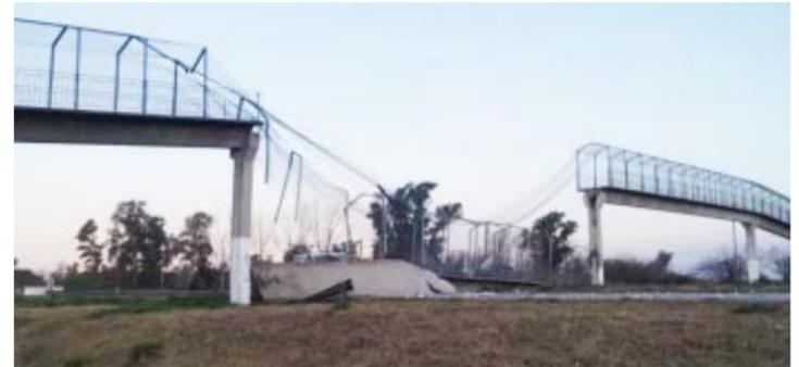
Un camión de gran porte, que transportaba una pala retroexcavadora, chocó y derribó un puente peatonal en el kilómetro 83,5 de la ruta 5 y el accidente generó caos vehicular.
